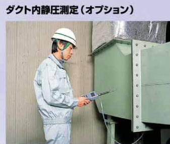
ダクト内静圧測定(オプション)
